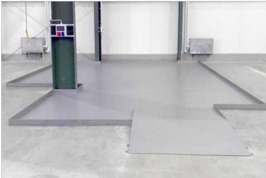
Bodembeschermbekledingen met uitsparing voor pijlers en overrijdplaten
